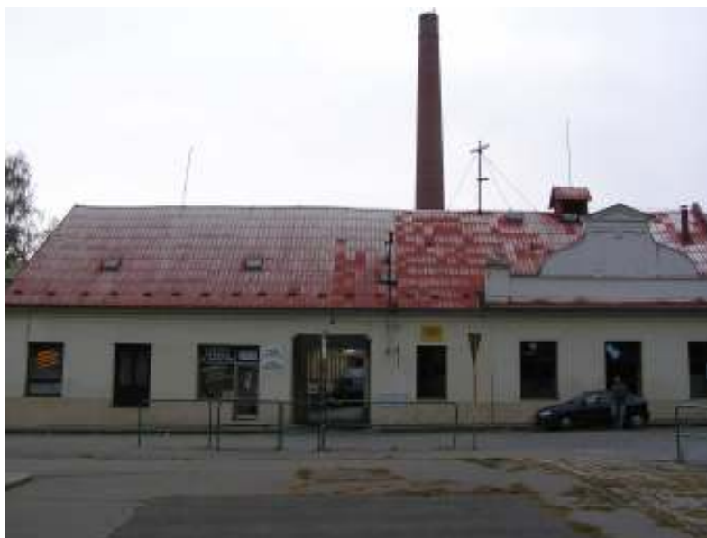
Obrázek 2 - Budova prádelny a čistírny
