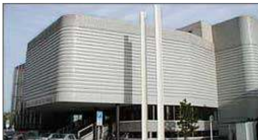
Obrázek č. 5 Budova Krajského úřadu Královéhradeckého kraje
