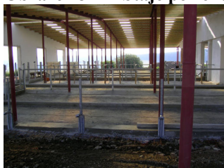
Obrázek 3-4 – Stáje po rekonstrukci
