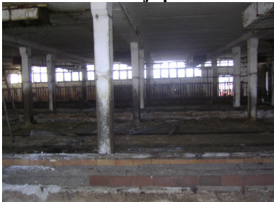
Obrázek 3-2 – Stáje před rekonstrukcí
