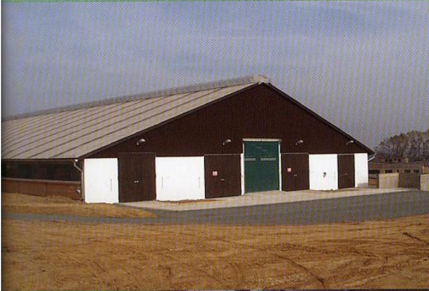
Výstavba stáje Zbizuby
