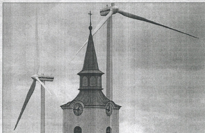
Zatím nejvyšší větrné elektrárny v Česku stojí v obci Pavlov na Jihlavsku. Měří 150 metrů. Zkušební provoz prvních větrníků na Vysočině zahájila firma KV Ventí 2. srpna.
