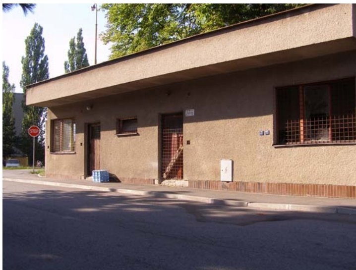
Obrázek č. 7: „pod střechou“
