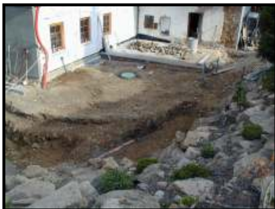
Přístavba a budování základů jezírka
