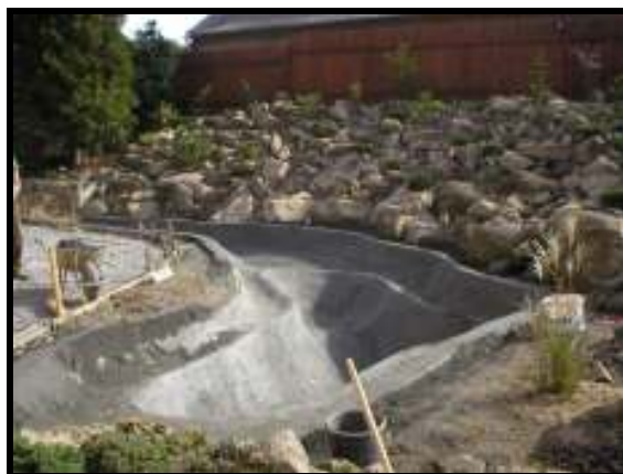
Skalka a vybetonované jezírko
