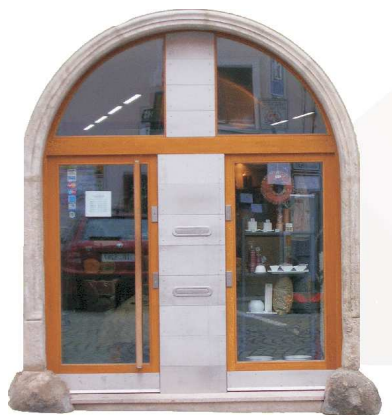
Obrázek č. 26 Moderní zateplená vrata
