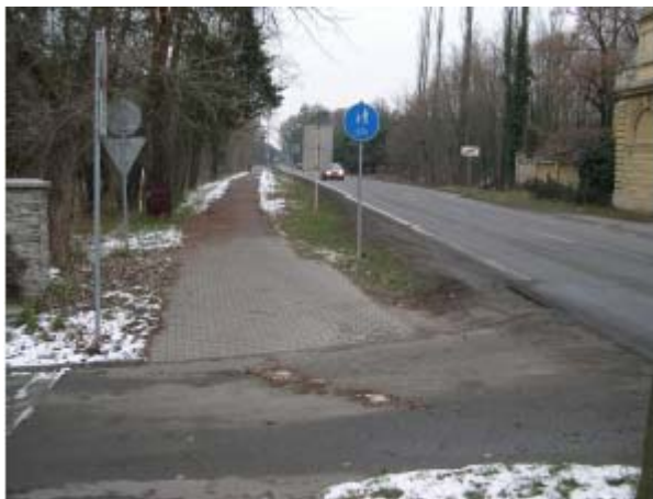
Obr. č. 5 Cyklostezka v ulici Veltrubská
