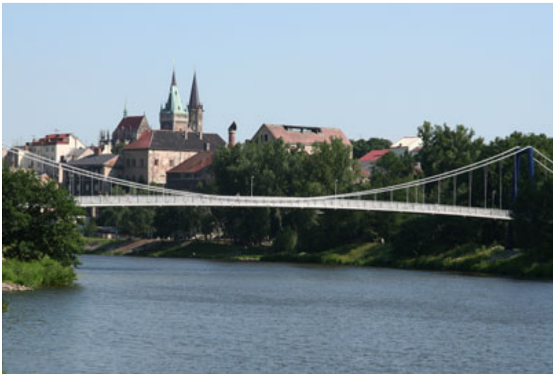
Obr. č. 6 Lávka přes Labe
