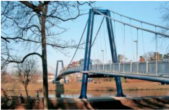
Obr. č. 5 Lávka přes Labe
